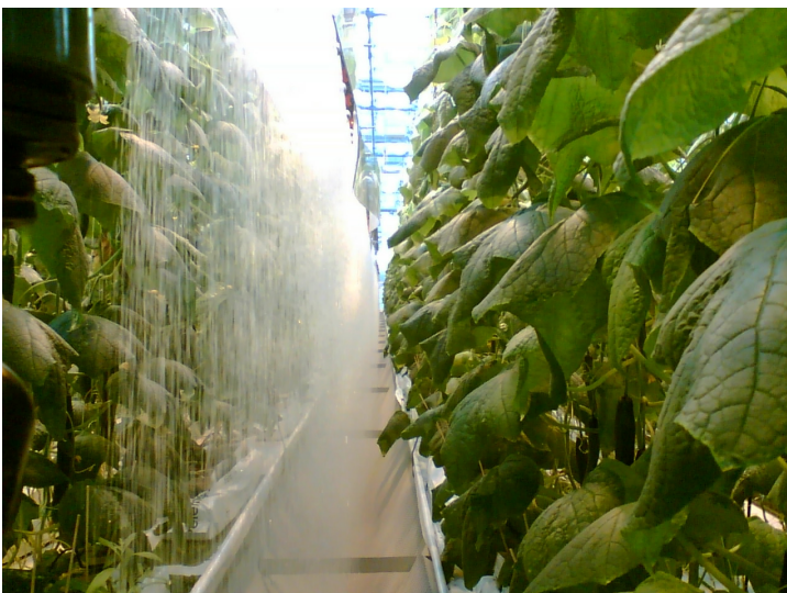
Kuva 2. Novarbo-pisaraverholla jäähdytetty kasvihuone Härkälän puutarha, Köyliö
